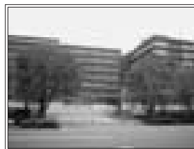
外務省 (耐震工事中)
