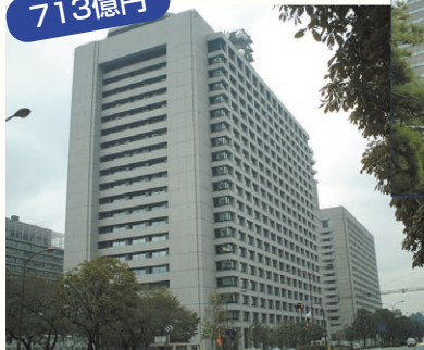
中央合同庁舎2号館〈総務省・警察庁・国土交通省〉 （高層棟は平成13年完成、低層棟は工事中）
