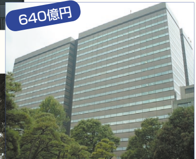
中央合同庁舎6号館〈法務省ほか〉 （平成2年、6年完成）
