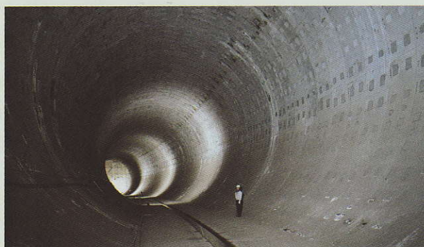
第一期トンネル
