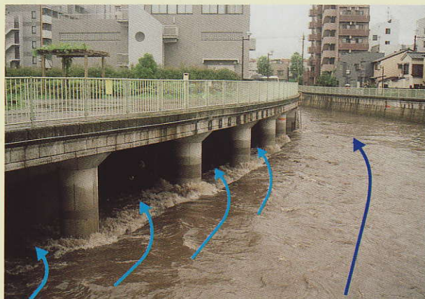
神田川取水施設への流入状況
