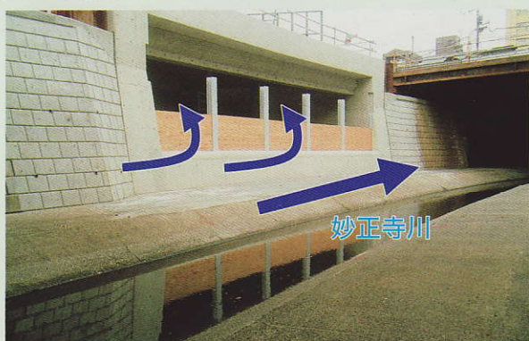
妙正寺川取水施設・取水口
